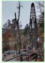
▲川俣地区掘削現場
