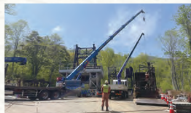
櫓の設置状況
