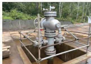
坑口装置の設置状況
