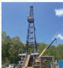
櫓の設置完了
